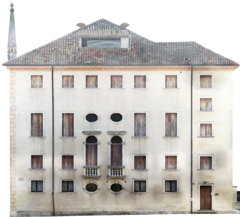
Fig. 7: Ortofoto della facciata nord
