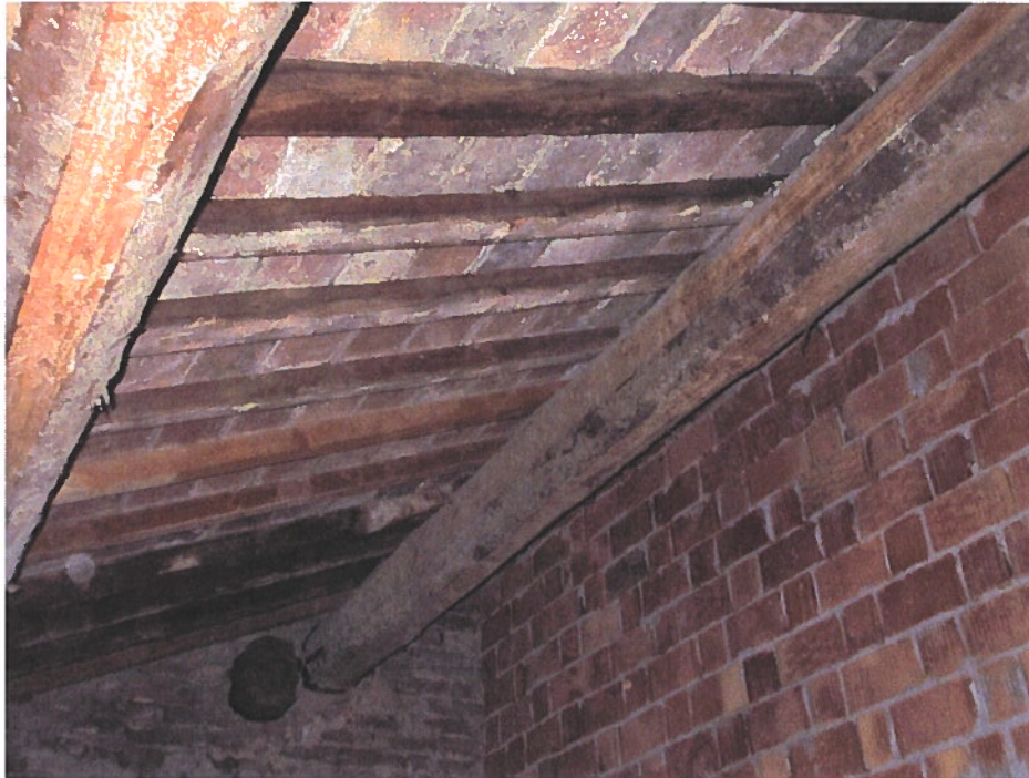
Foto n. 19 Tetto dal controsoffitto lato Sud-Ovest
