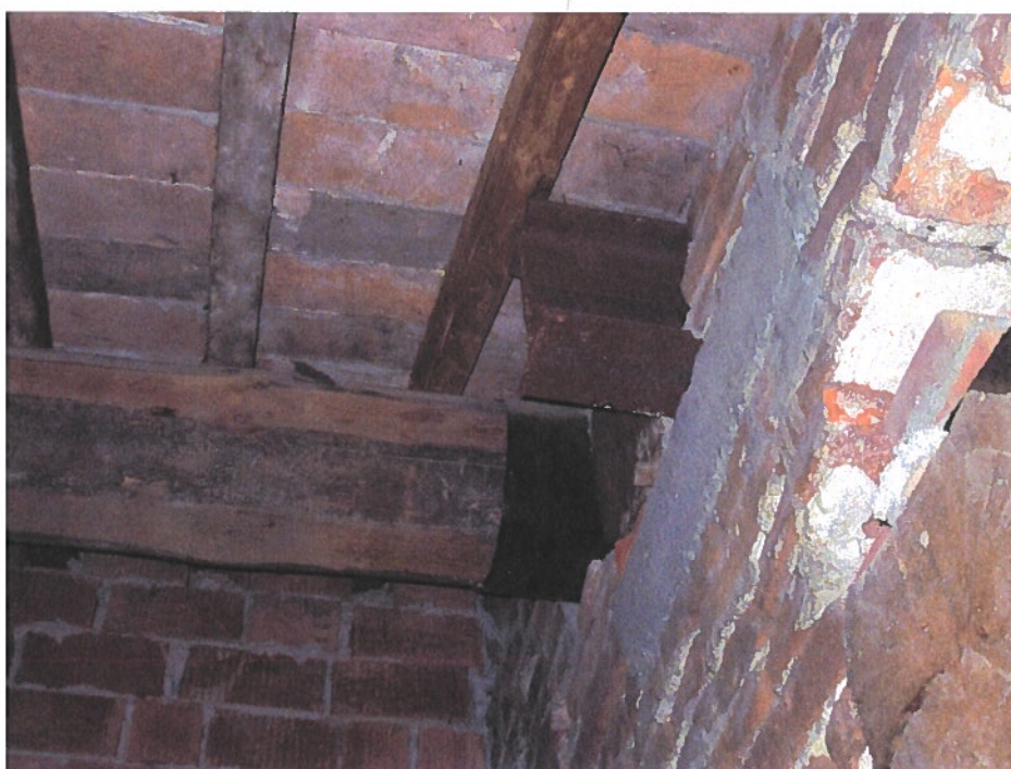
Foto n. 16 Tetto dal controsoffitto lato Sud-Ovest
