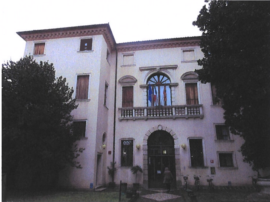
Foto n. 1 Facciata su Corso del Popolo
