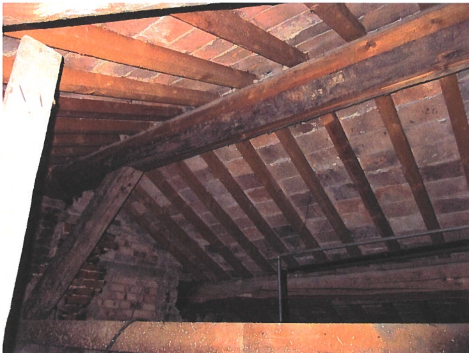
Foto n. 4 Tetto dal controsoffitto lato Nord-Est
