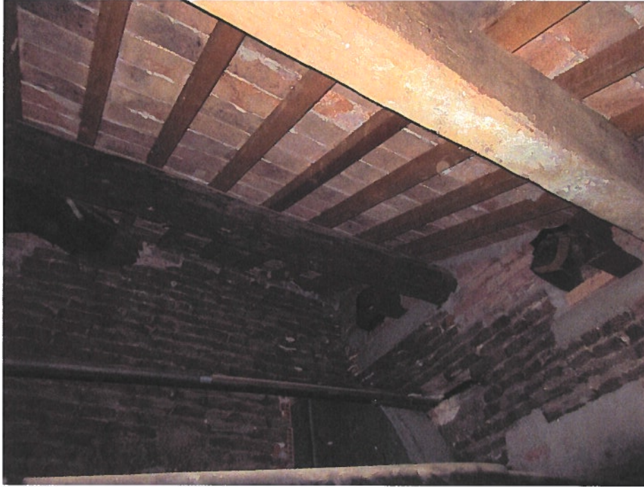
Foto n. 5 Tetto dal controsoffitto lato Nord-Est
