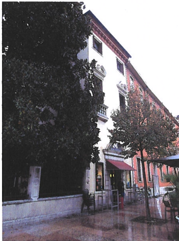
Foto n. 2 Facciata su Corso del Popolo
