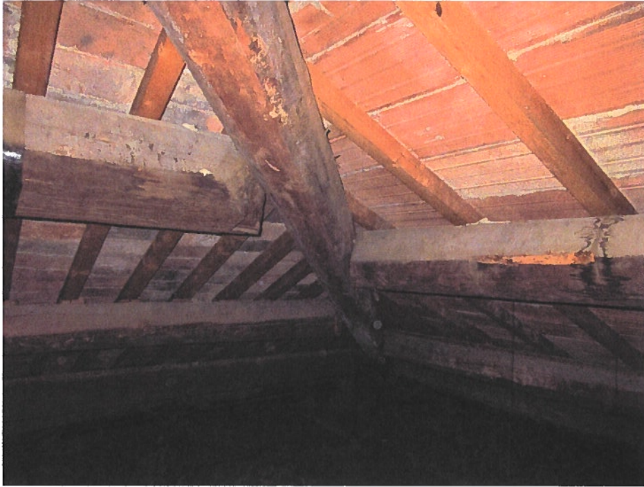
Foto n. 9 Tetto dalla botola lato Nord-Est
