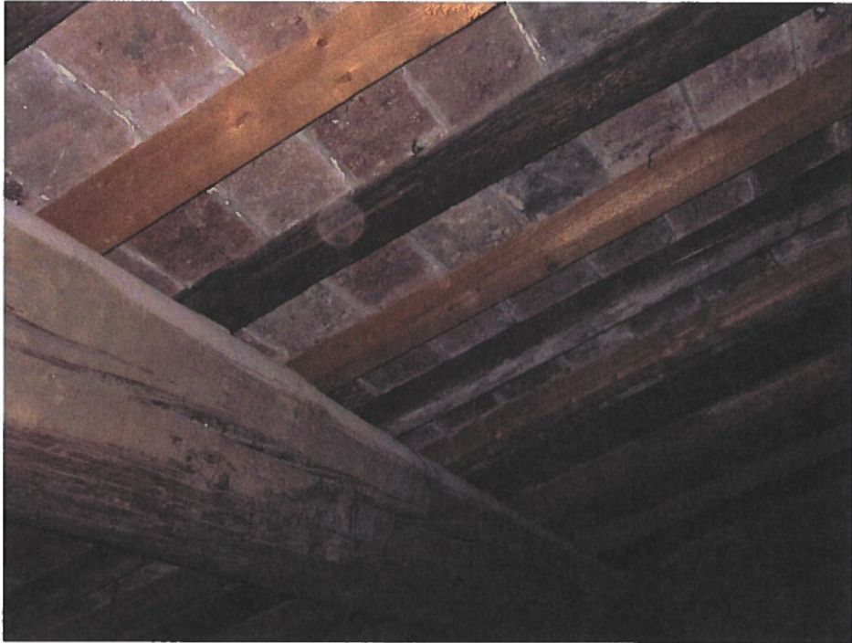
Foto n. 17 Tetto dal controsoffitto lato Sud-Ovest
