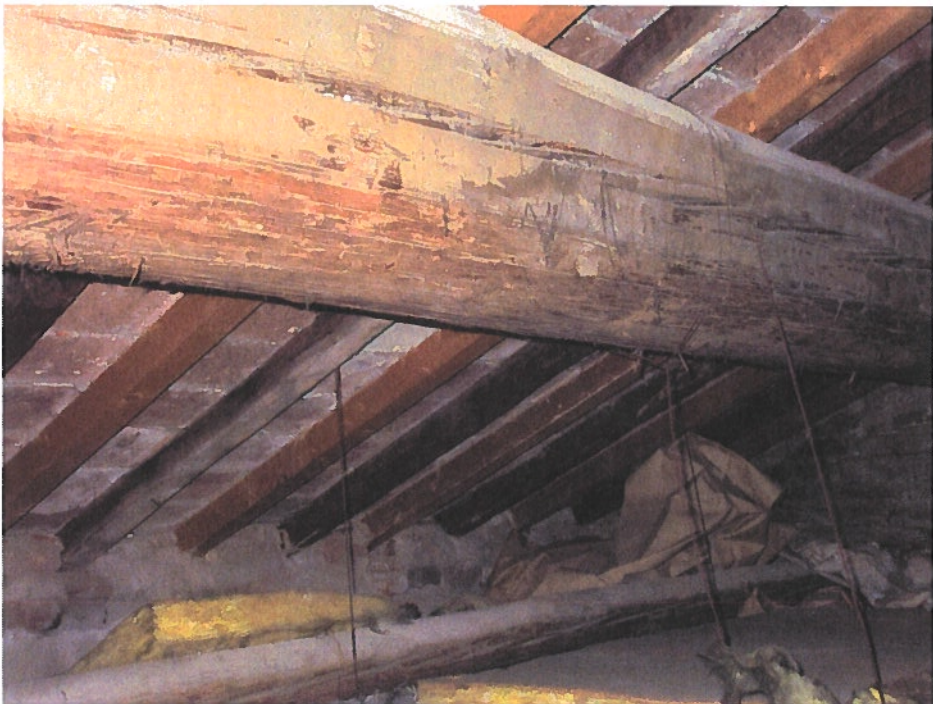
Foto n. 18 Tetto dal controsoffitto lato Sud-Ovest
