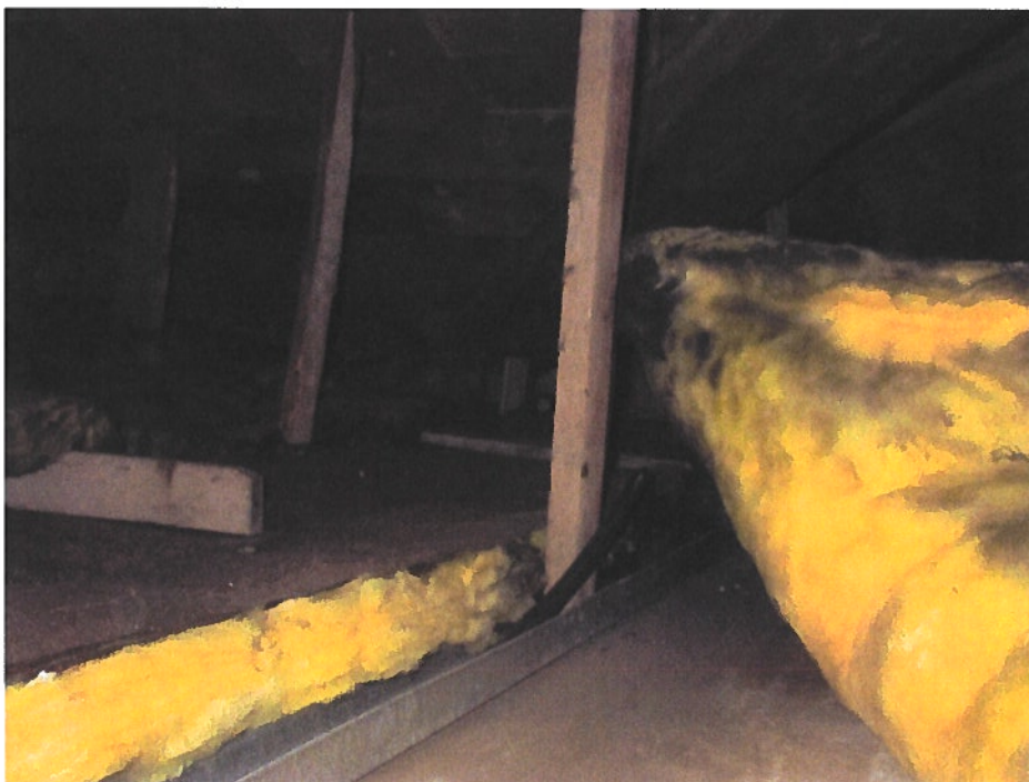
Foto n. 8 Tetto dal controsoffitto lato Nord-Est
