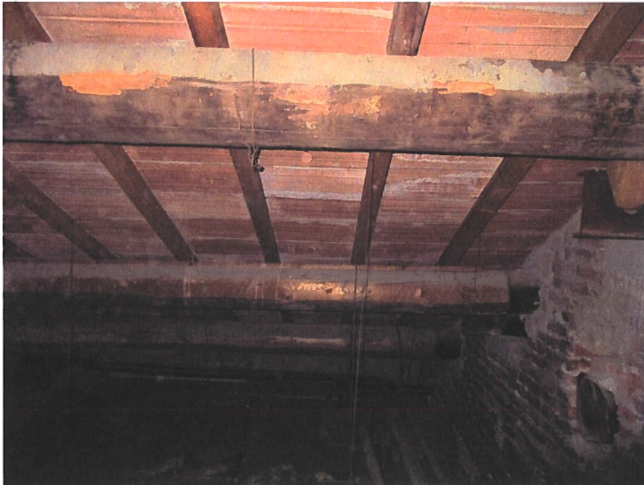
Foto n. 10 Tetto dalla botola lato Nord-Est
