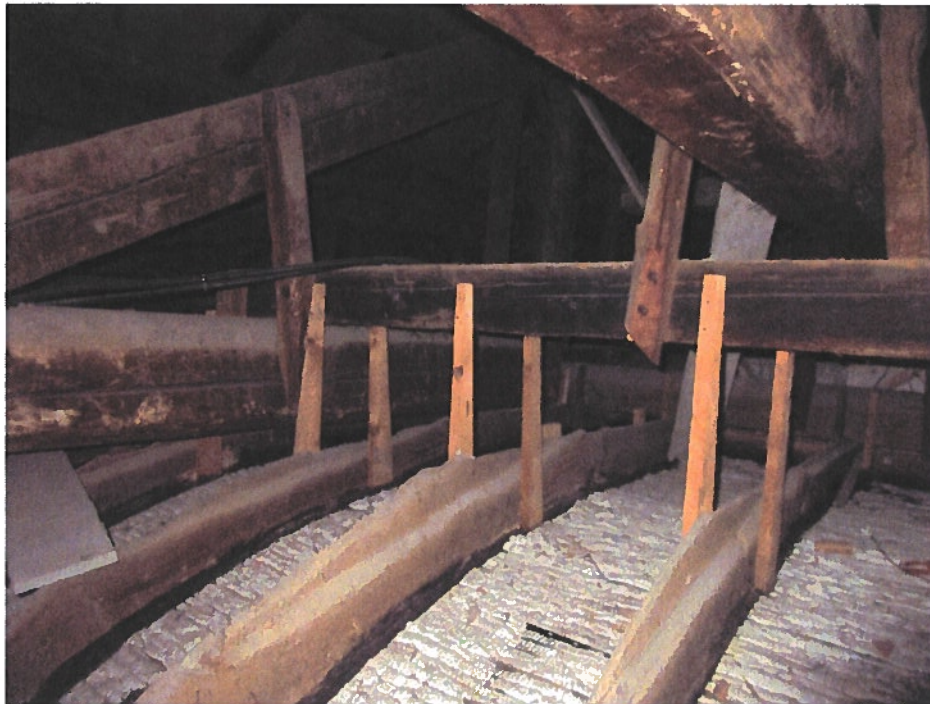
Foto n. 13 Volta in legno e incannucciato sul Salone
