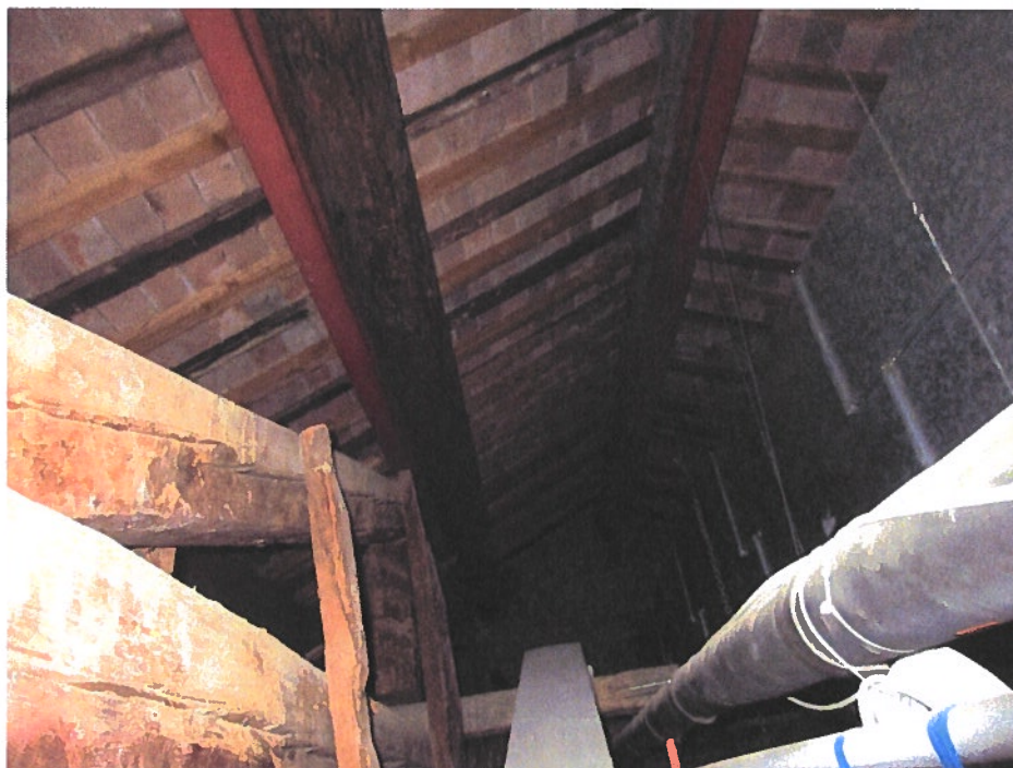
Foto n. 15 Tetto sul Salone
