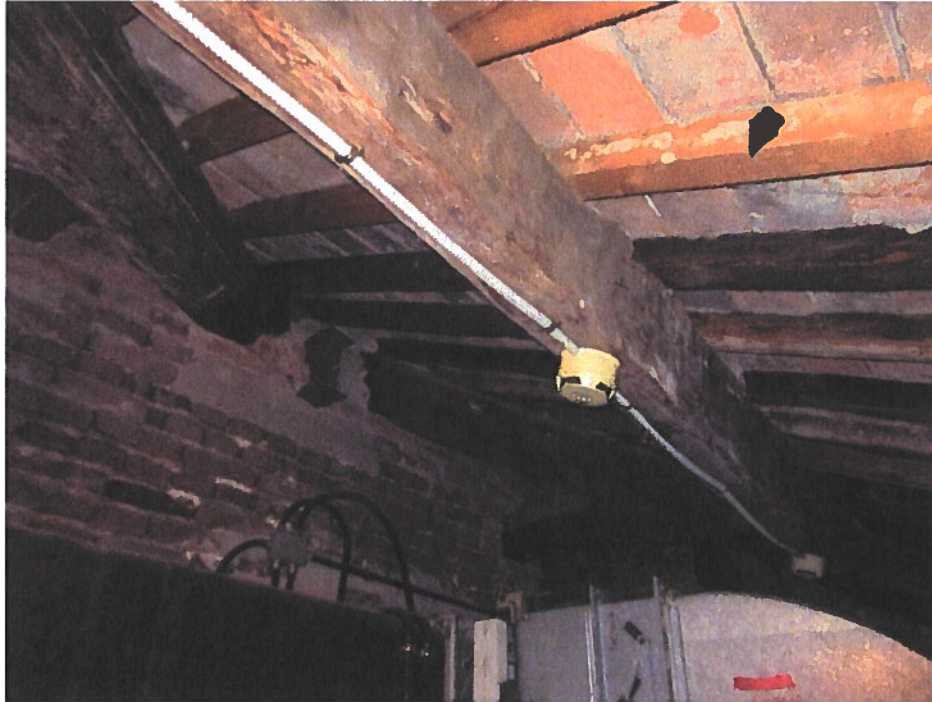
Foto n. 11 Tetto dalla botola lato Nord-Est
