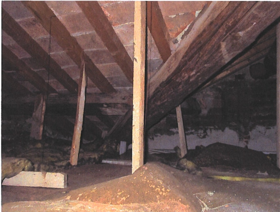
Foto n. 7 Tetto dal controsoffitto lato Nord-Est
