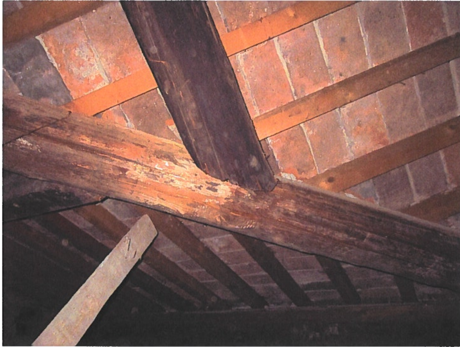
Foto n. 3 Tetto dal controsoffitto lato Nord-Est
