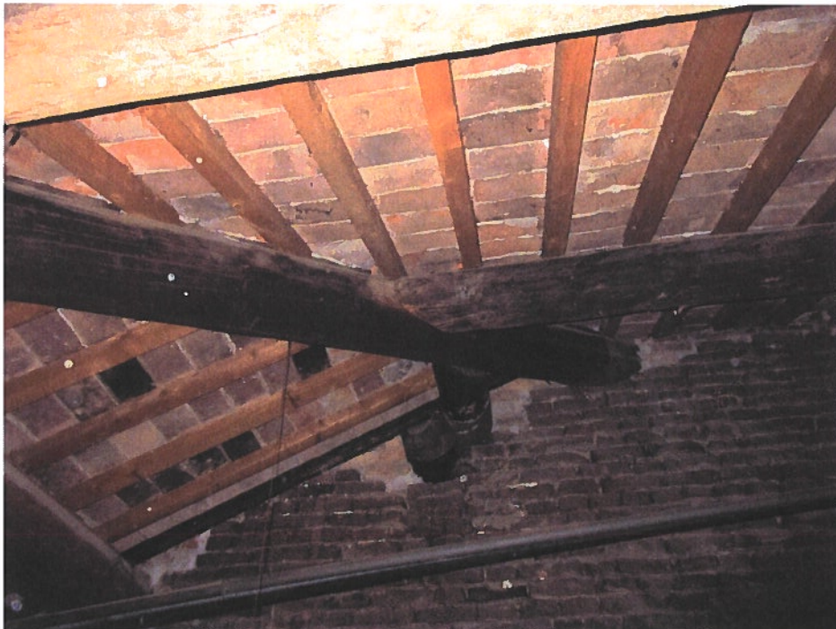
Foto n. 6 Tetto dal controsoffitto lato Nord-Est
