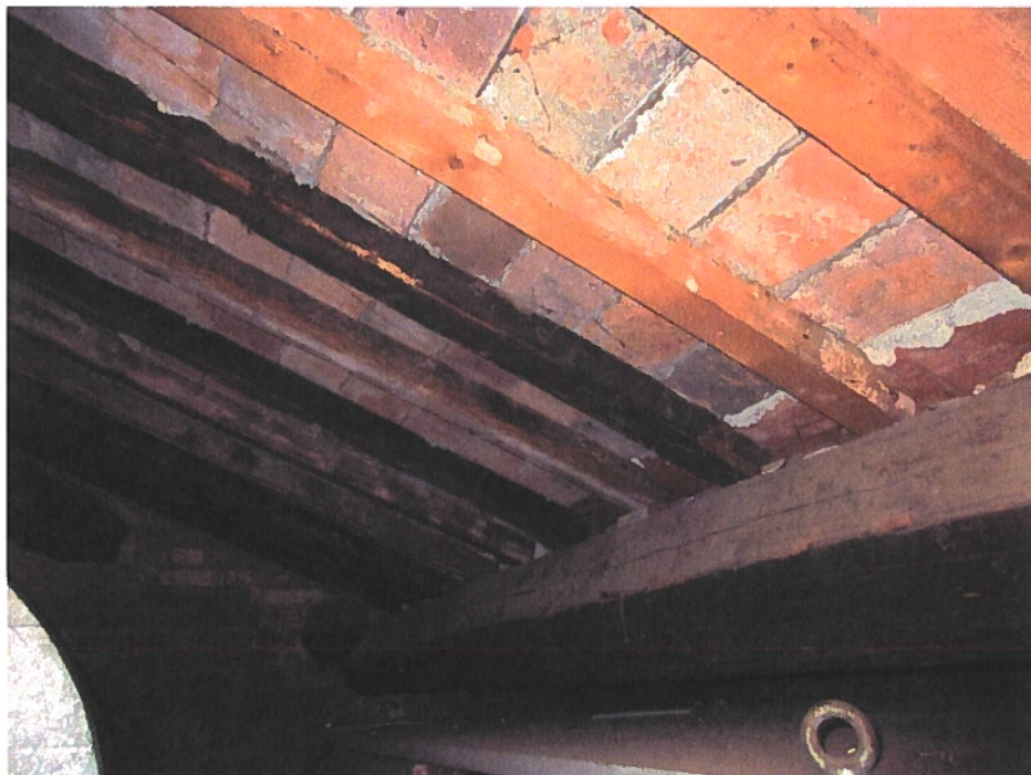
Foto n. 12 Tetto dalla botola lato Nord-Est
